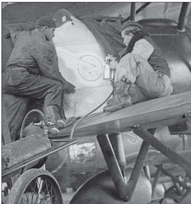
5. ábra. Készül a századjelvény: a festési munkálatok szórópisztolyos fázisa
