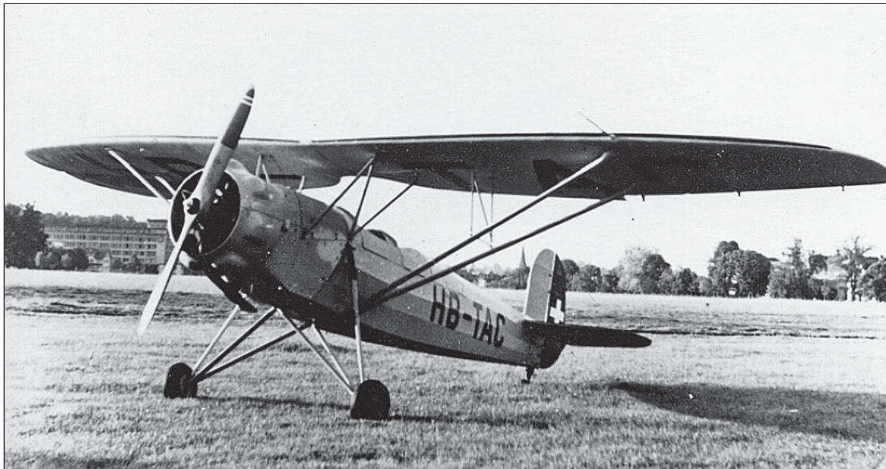
41. ábra. Siemens csillagmotorra átalakított gép Svájcban
