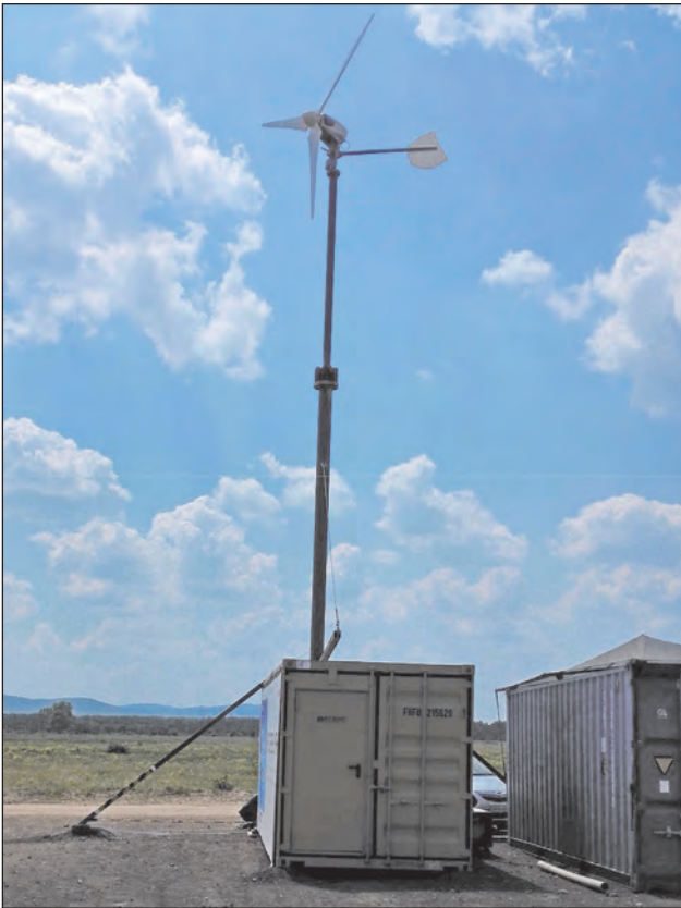
14. ábra. Mivel még a kábeleket is betemették, ha nem lenne az áruklodó szélturbina, semmi sem mutatná, hogy ebben a konténerben található a Pfisterer MEMS-e
