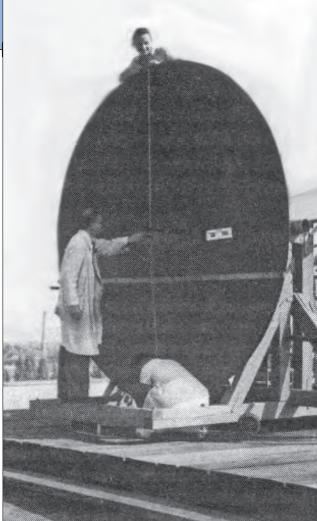
5. ábra. Borbála rádiólokátor parabola antennája az Egyesült Izzó egyik épületének tetején
