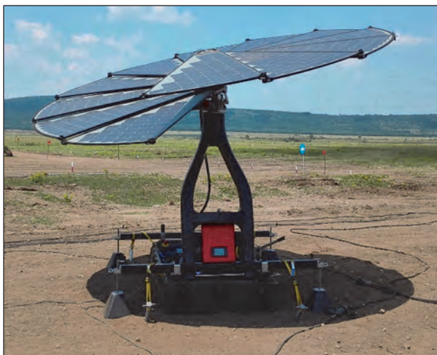
7. ábra. A Smartflower. Az „okos virág” nemcsak automatikusan kinyílik a hordozó dobozából, de követi is a napot
