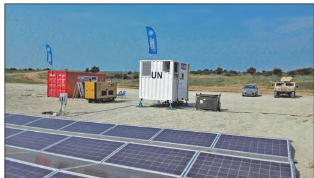
11. ábra. Az ESTechnologies berendezése a zöld konverteren keresztül, két héten át látott el egy klimatizált sátoztáborot villamos energiával
