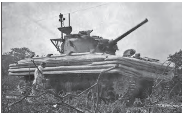
8. ábra. A Sherman „DD” harckocsi összehajtott Straussler-féle úszóköpennyel
