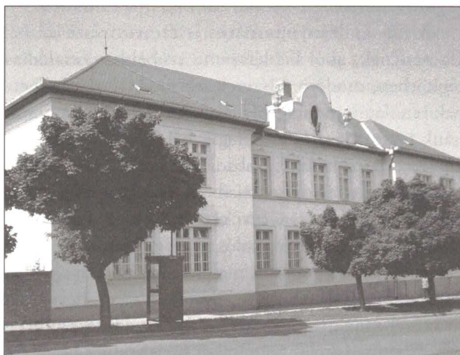
Az általános iskola épülete
