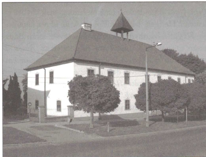
Az „első iskola” épülete
