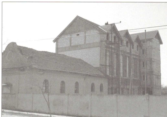
Épülő baptista imaház, Arad-Gáj (38. o.)
