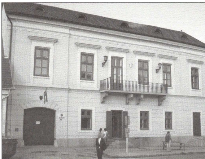
A Pápai Református Kollégium Tatai Gimnáziumának épülete (épült 1853-ban)
