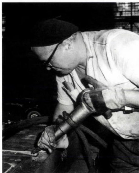
1. ábra: Öntvénytisztító munkás légkalapáccsal
