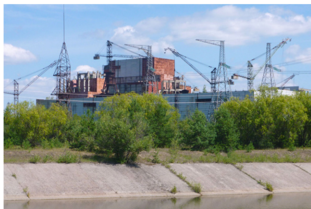
8. ábra. Az 5. és a 6. „épülő” blokk maradványai.
