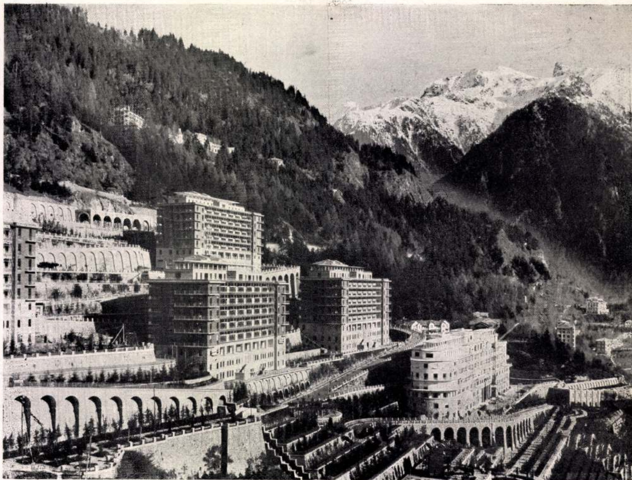
A sondalói sanatorium-város betegpavillonjai. (Jobb oldalt alul a fehér épület a sebészet).
