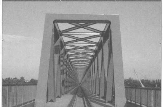
18. ábra: Az Északi vasúti Duna-híd korszerűen kialakított szerkezetének látványa keresztmetszet (Dr. Domanovszky Sándor felvétele)
