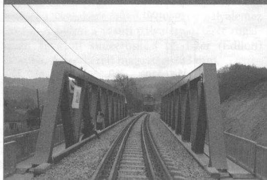
13. ábra: A 2112. sz. főút vasúti felüljáró, próbaterhelés (Legeza István felvétele)
