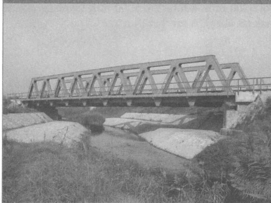
5. ábra: Gaja-patak híd oldalnézete (Szánthó Géza felvétele)
