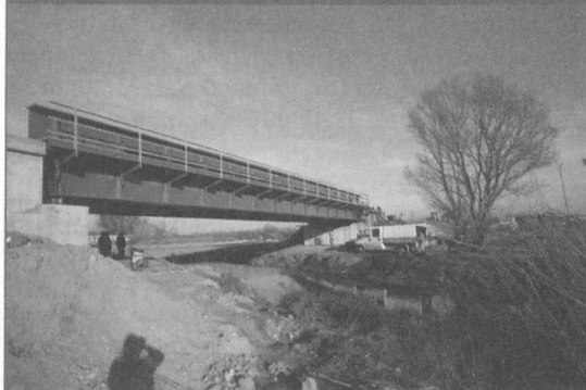
20. ábra: A Marcal-híd építés közben (a SpeciálTerv Kft. felvétele)
