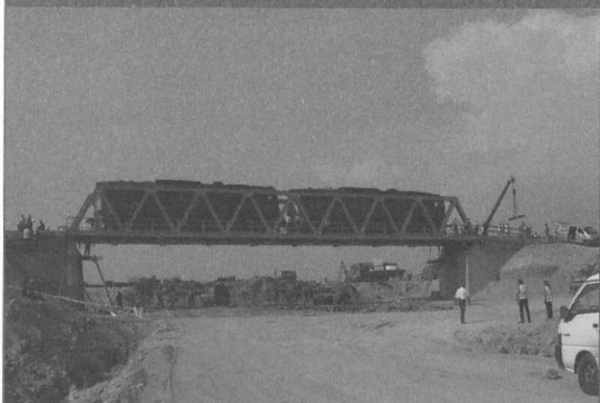
14. ábra: A 71. sz. főút vasúti felüljáró próbaterhelés (Sujtó Géza felvétele)
