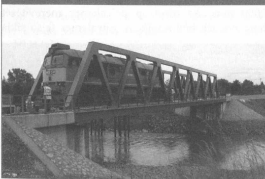
23. ábra: A Lapinca-híd próbaterhelése (Legeza István felvétele)
