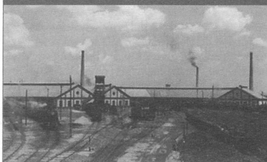
1. ábra: MÁV Északi Fűtőház
