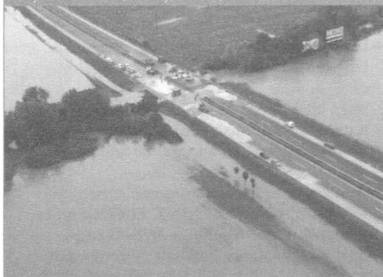
4. ábra: Az M1-es autópályán a Cuhai Bakony-ér áradása által 2010. május 19-én okozott károk helyreállítása. (Pálfay, 2010)
