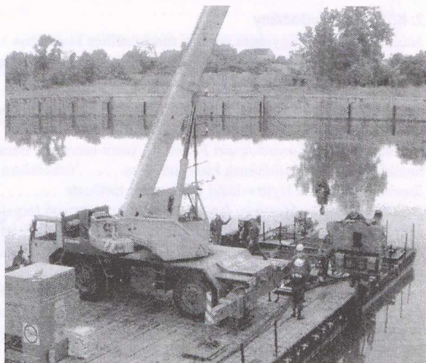
3. ábra Összeállított 14 részes hídmező lemezhúzás közben
