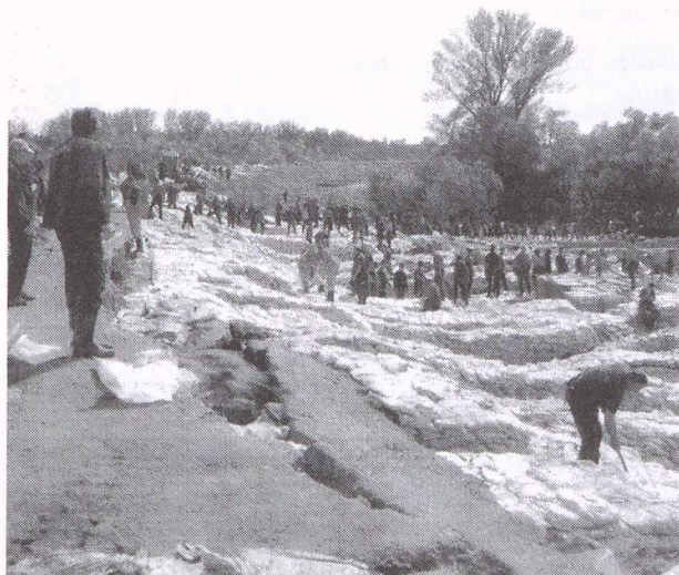
2. ábra Rézsú megtámasztás Csépa-Szelevénynél
