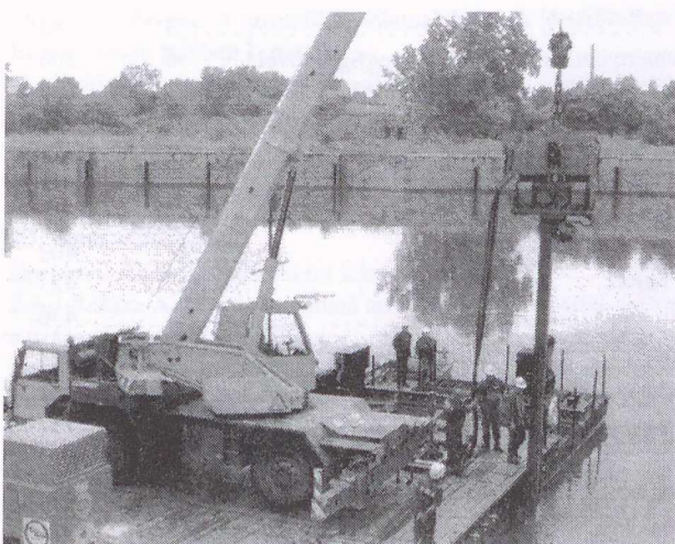
4. ábra 14 részes hídmező szádlemez verés közben
