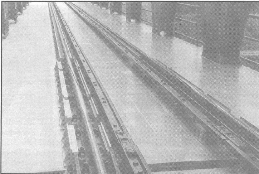
14. ábra: A rugalmasan beágyazott sindilatációs készülék a simontornyai hídon
