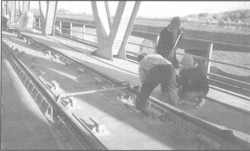
13. ábra: Vágánybeállítás a simontornyai Sió-hídon
