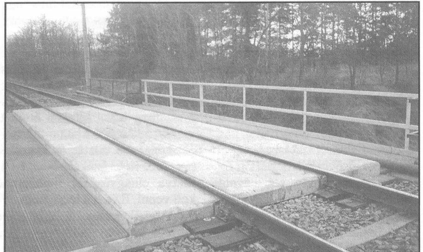
9. ábra: A balatonaligai vasúti felüljáró felszerkezete
