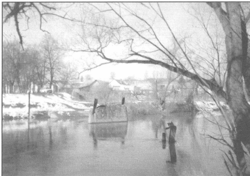
11. ábra A múlyadi híd roncsai
