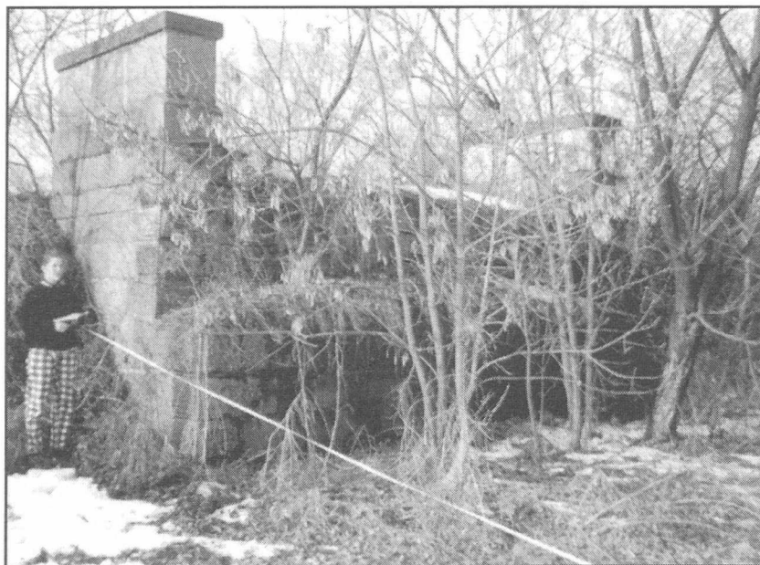
12. ábra A szlovák oldali hídfő (pöstényi híd)
