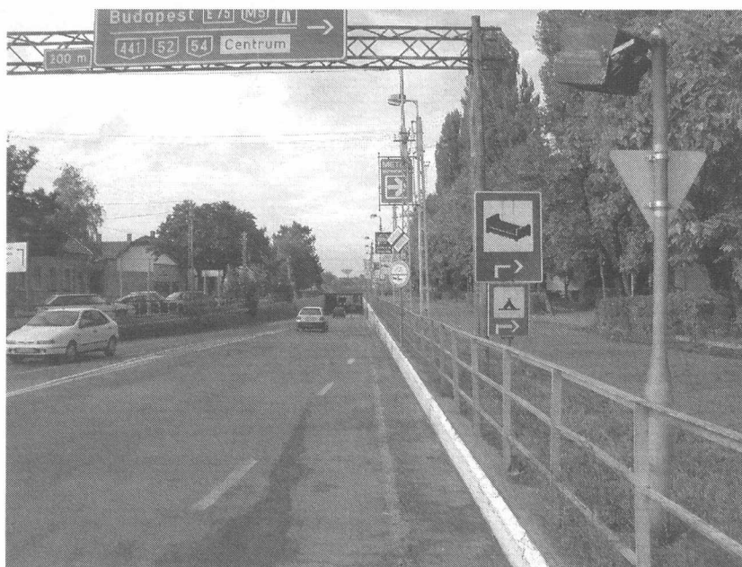
19. ábra A kecskeméti 1942-ben épített közúti aluljáró jelenleg
