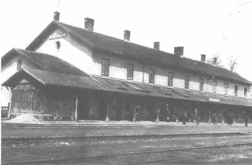
1. ábra Körös (Krizevci) állomás felvételi épülete
