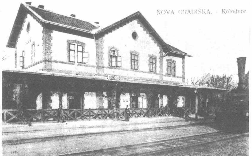
5. ábra Új-Gradiska. MÁV fővonalai II. osztályú felvételi épülete (1888)
