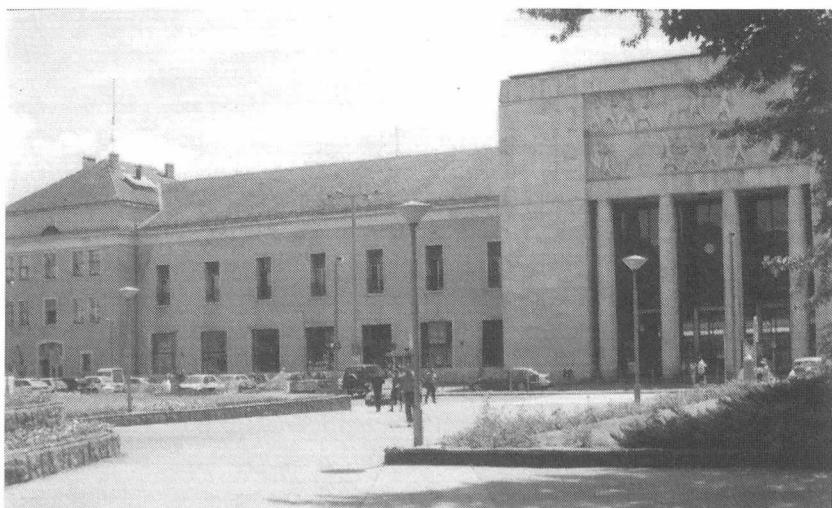
9. ábra Győr új felvételi épülete
