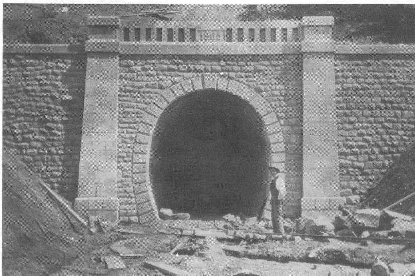
14. ábra Uzsoki alagút bejárata
