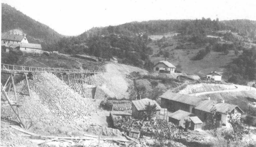
12. ábra Töltésépítés a Nagyberezna – uzsoki vonalon
