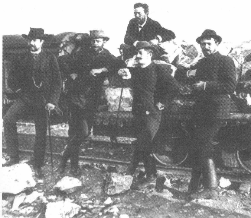
17. ábra A vasútépítést irányító felügyelőség mérnökei
