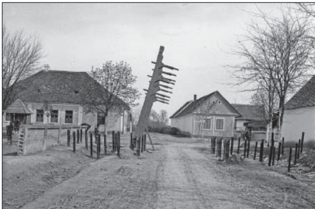
83. ábra. Útakadály Petlovac falu központjában (Fortepan 71479)
