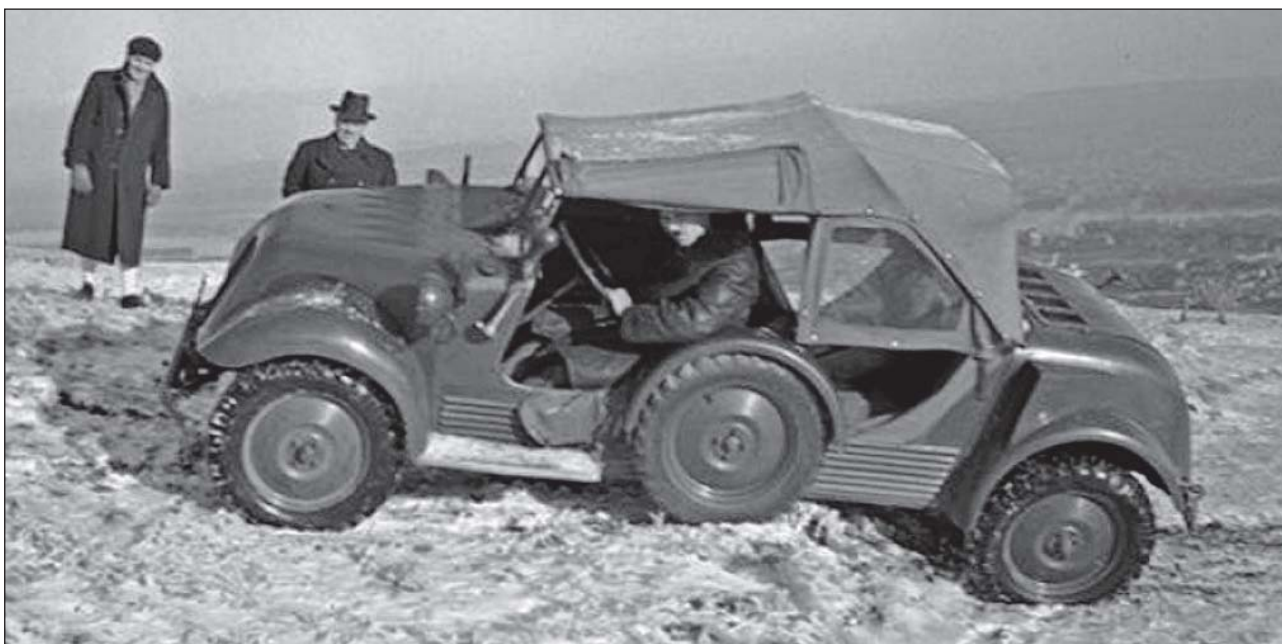
14. ábra. A Buda Elektromos Művek Tempo G 1200-as terepjárója. Helyzete jól szemlélteti az elforogni képes pótkerék szerepét
