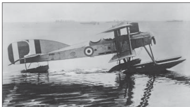
5. ábra. Short 184-es vízi repülőgép. Az ENGADINE-ről vízre tették, majd a feladat végrehajtása után daruval kiemelték a vízből
