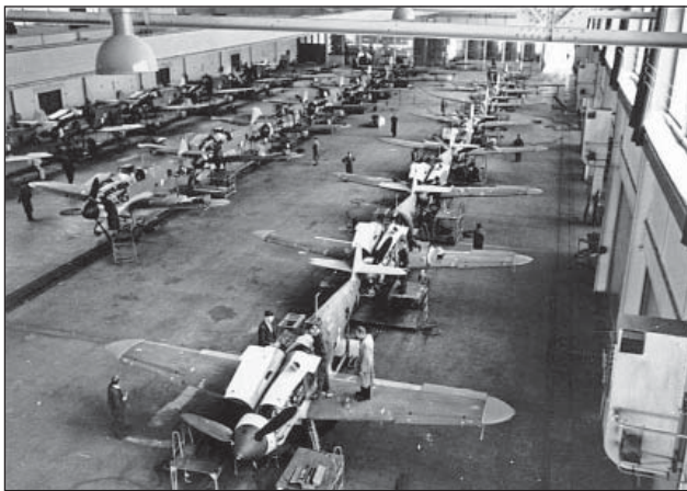
15. ábra. Az Me 109-es gyártása. Hazánkban 723 db-ot gyártottak ebből a típusból a II. világháború alatt
