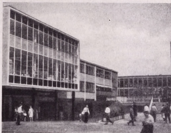
Stevenage városközpontjának főtere Jól látható a tér erős szintbeni tagolása. A régi növényzetet nagy gonddal illesztik be az építészeti együttesbe
