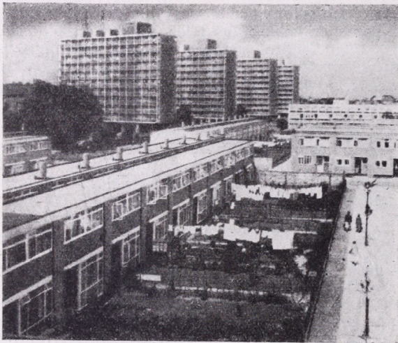
London. Loughborough Road lakótelep. Magas bérházak és telkes családi sorházak együttes alkalmazásának példája. A telkek a kert felől is megközelíthetők, ami sok utat igényel. Az egyéni kertek használhatósága, izolálhatósága nagyon vitatható
