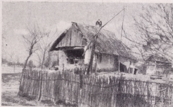
Mesterséges dombhátra épített vályogfalú lakóház
