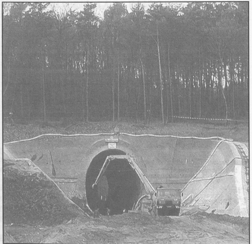
Zalalövő-Hódos közötti új vasútvonalon épülő Balla-hegyi (Zsuzsanna) alagút
