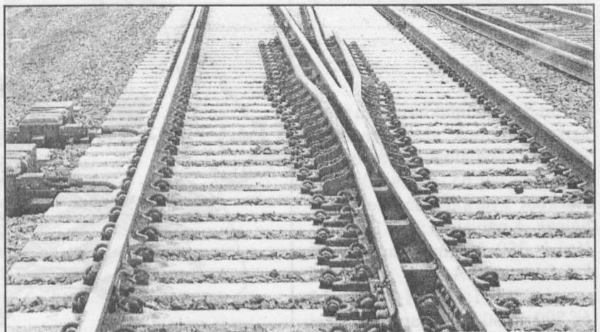
33. ábra: A VAE mozgó könyöksínes kitérője
