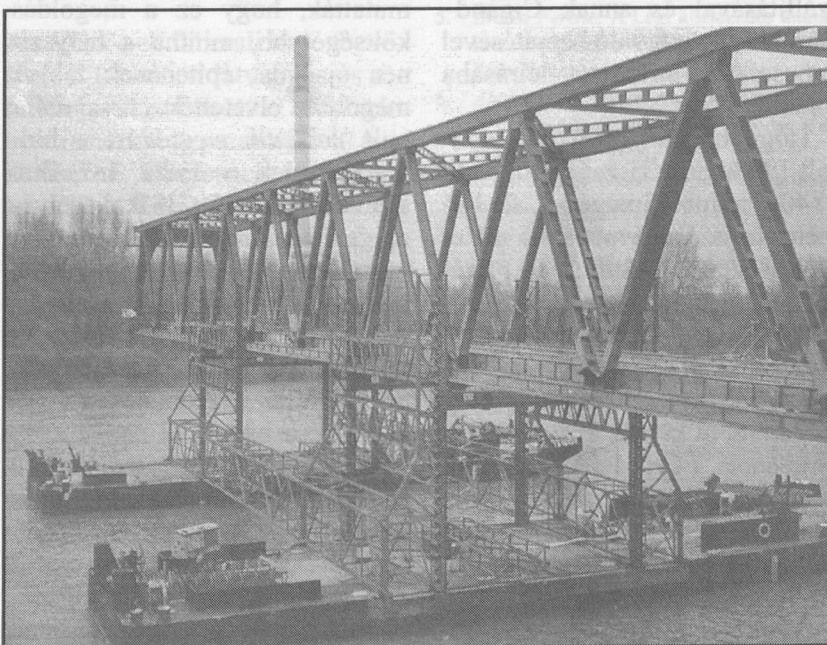
3. ábra A hídszerkezet süllyesztése
