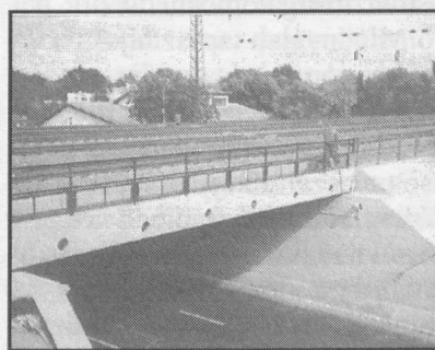
2. Az elkészült Fető úti híd
