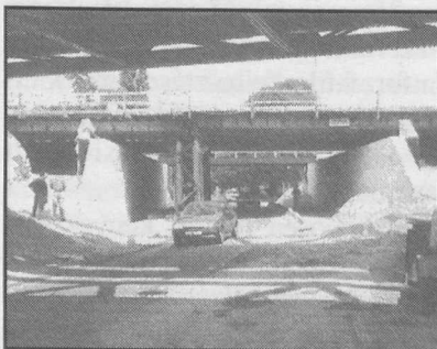
1. Budapest-Fertő úti hidak falazatainak építése
