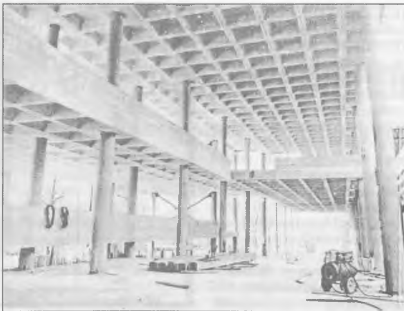
10. ábra A kazettás monolit vasbeton födémrendszer
