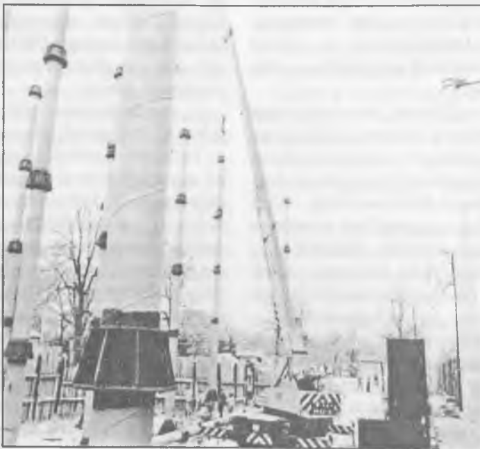
9. ábra A 400 mm átmérőjű spirálhegesztésű acélcsövek beállítása, gombafejekkel felszerelve
