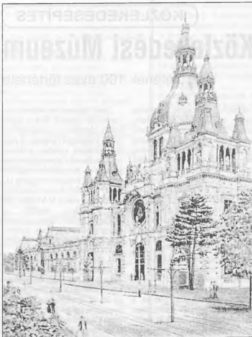
1. ábra A közlekedési csarnok főbejárati része a kupolával
