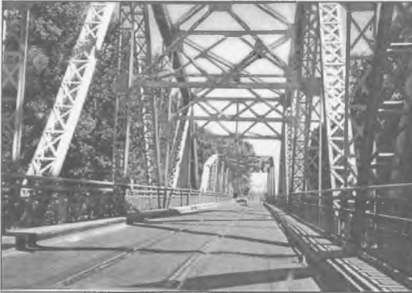
10. ábra A korszerűsítendő vegyes forgalmú tiszai Tisza-híd
