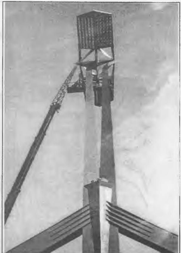
7. ábra A lágymányosi közúti Duna-híd pilonján az újszerű világítás műanyag tükreinek szerelése
