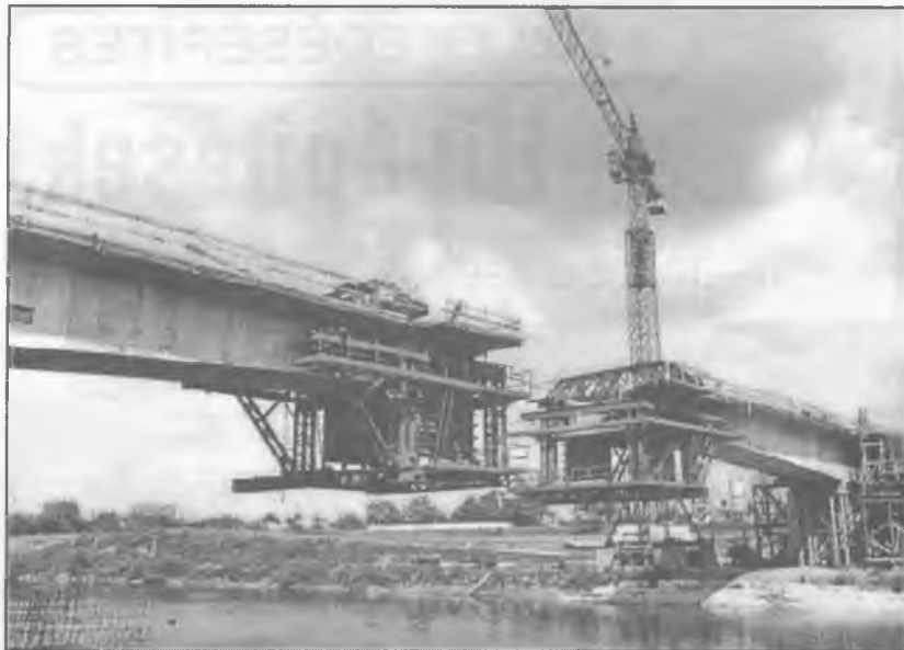
3. ábra Szabadon betonozott feszített vasbeton szekrénytartós híd építése Szolnokon
