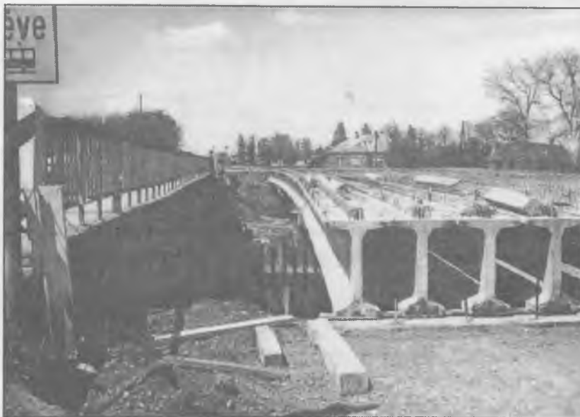
1. ábra Előregyártott hídderendákból épülő híd (rumi Rába-híd)
