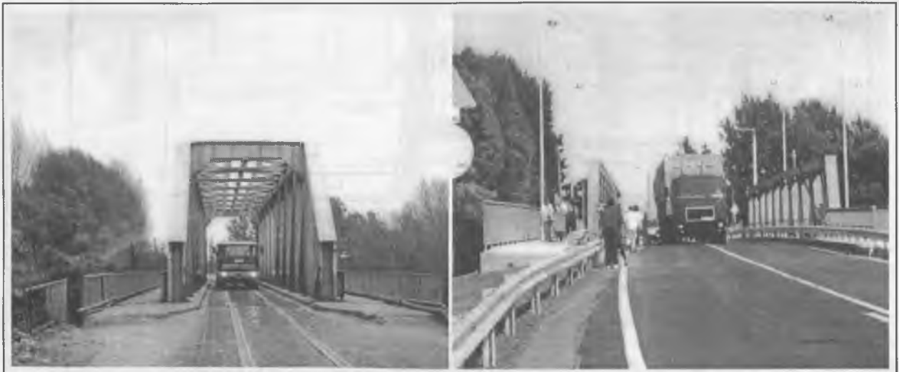
14. ábra A taksonyi Kis-Duna-híd korszerűsítés előtt és után
