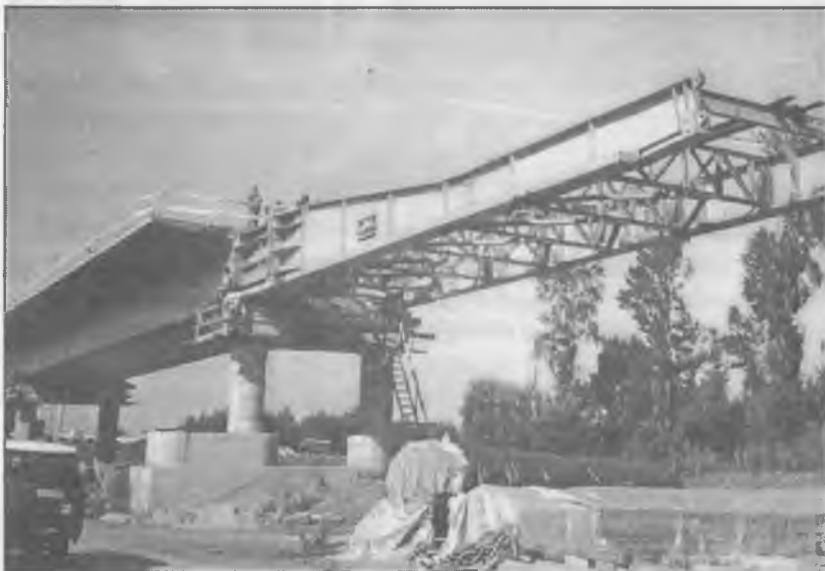
4. ábra A szolnoki Tisza-híd ártéri szerkezetének építése szakaszos betonozással és toléssal
