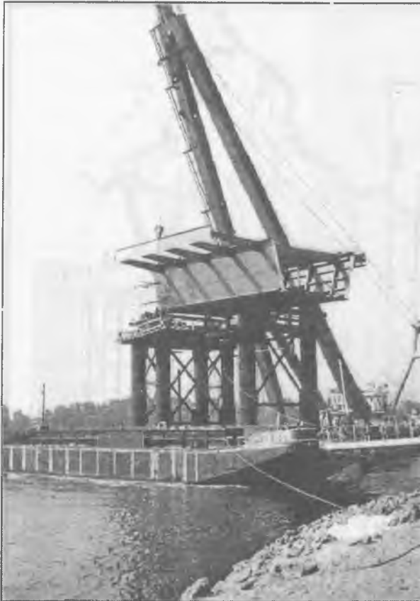
6. ábra Az MO hárosi Duna-híd acél felszerkezetének szerelése Clark Ádám úszódaru segítségével
