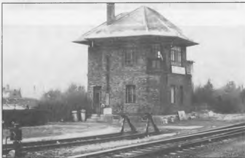
20. ábra A MÁV állítótorony. Celldömölk. 1910-ben épült. A felvétel 1991-ben készült.
