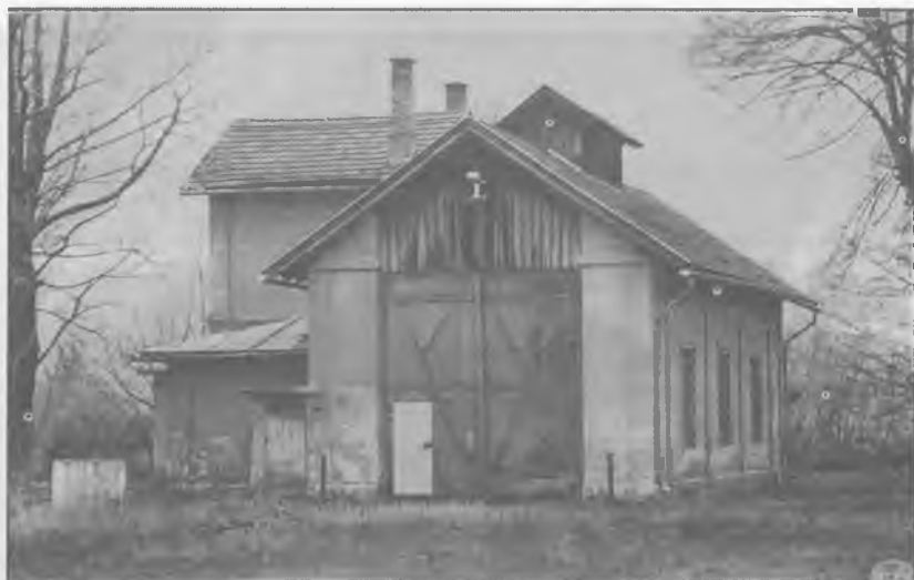
18. ábra Helyiérdekű vasút fűtőháza vízházzal és kisebb javítóműhellyel. Romhány. 1909. A felvétel 1992-ben készült.
