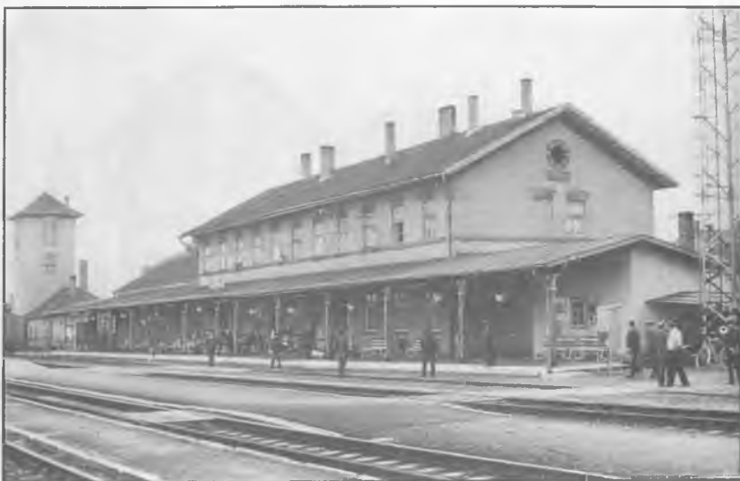
10. ábra A Magyar Nyugoti Vasút "Másodosztályú felvételi épülete" Sárvár állomáson. (Épült 1871-ben, a felvétel 1988-ban készült.)
