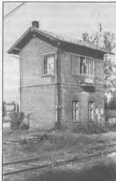
19. ábra Déli Vasúti állítótorony. Barcs.
