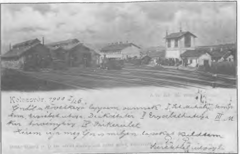
17. ábra 20 mozdonyállású, ötvágányos, háromajtós MÁV fűtőház, mely szabványtervek alapján épült Kolozsvár állomáson. A felvétel 1900 előtt készült.
