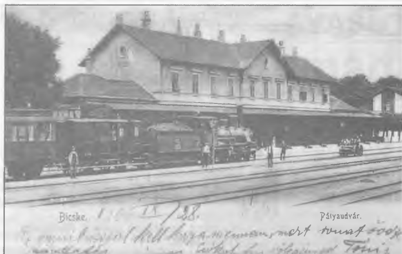
6. ábra A MÁV "Első osztályú felvételi épülete" a Kelenföld-Újszöny vonal részére. Bicske. Vakolt homlokzati kivitel. 1884. Felvétel 1910 körül.
