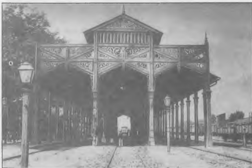
8. ábra A Tiszavidéki Vasút ácsolt csarnoka Püspökladányban. 1857. Ebből a szabványosított építményből a TVV vonalai mentén 8 épült.
