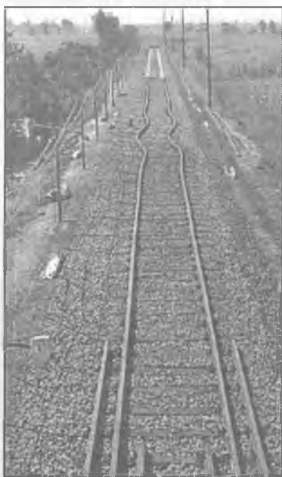
22. ábra Az egyenes 5 mm-es helyenkénti irányhibás vágány, kivetődése a végén látható megerősítéssel
