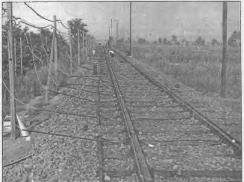
14. ábra A hatvani deltavágányban kísérletre előkészített első, 48-as sínrendszerű talpfás 192 m-es kísérleti vágány távlati képe
