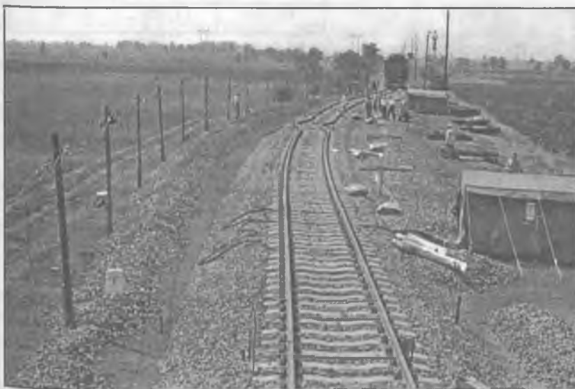
23. ábra Az R = 600 m-es sugarú, 5 mm-es helyenkénti irányhibás vágány kivetődése
