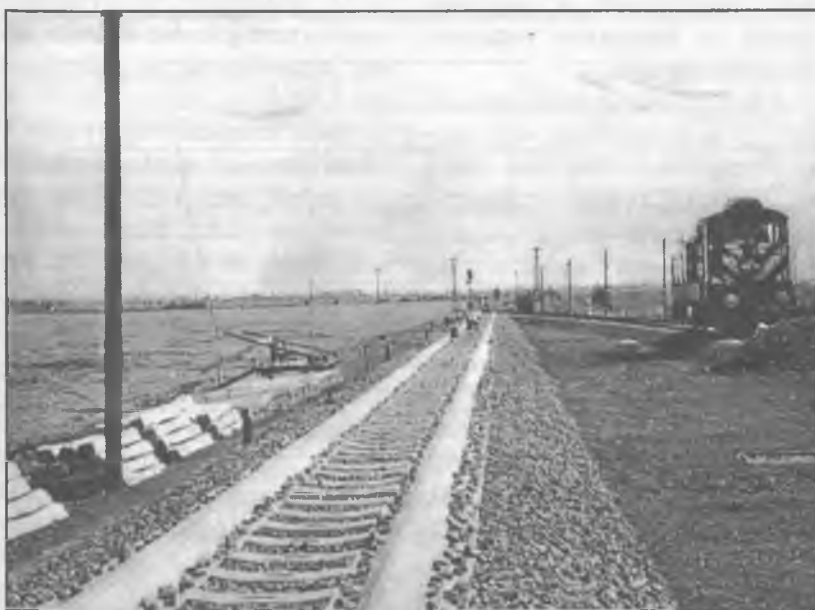
27. ábra A dinamikus kísérletre előkészített pálya, a sínek felmelegítését szolgáló M 44 sor. mozdonnyal
