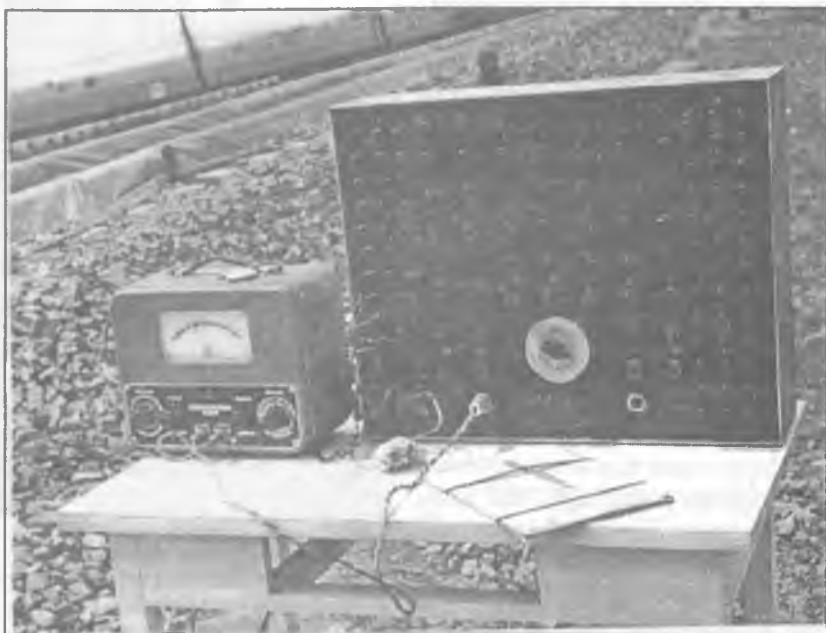
21. ábra A VTKI kifejlesztésű berendezés a hőfeszültségek megállapításához
