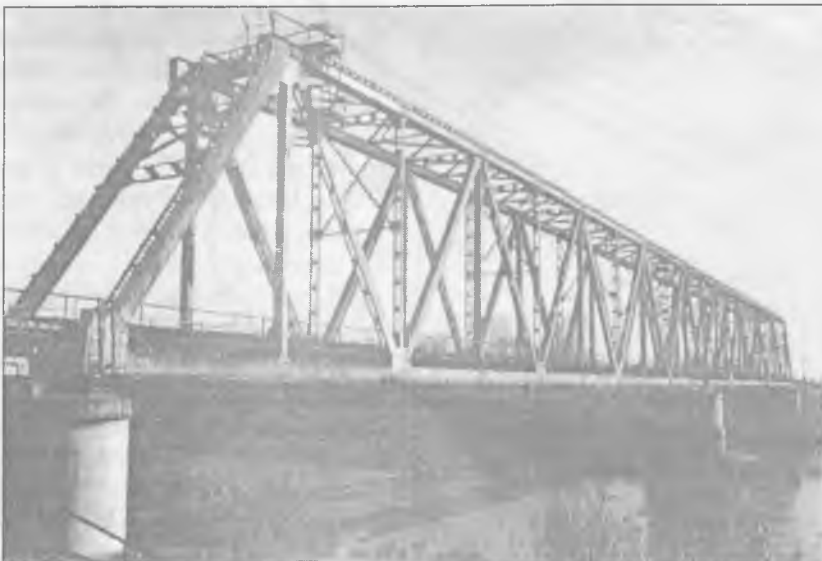
8. ábra: Új Tisza-híd Eperjeske és Bátyú között
