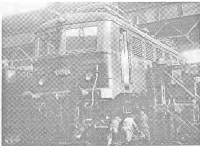
4. A V 55 tip. villamos mozdony javítása (Északi Főműhely, 1965)
