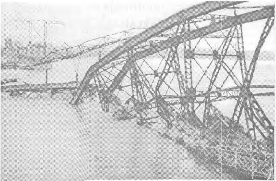
8. ábra A felrobbantott Déli összekötő Duna-híd.
