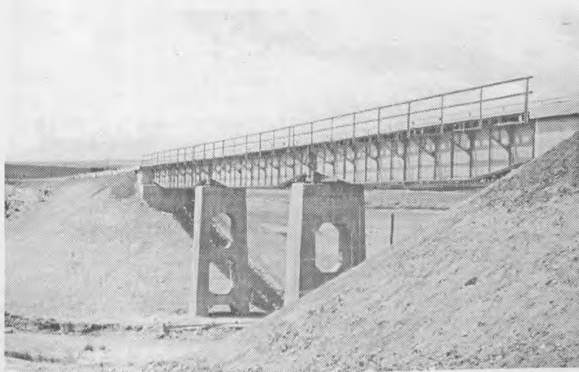
5. ábra A Nagyvölgyi vladukt
