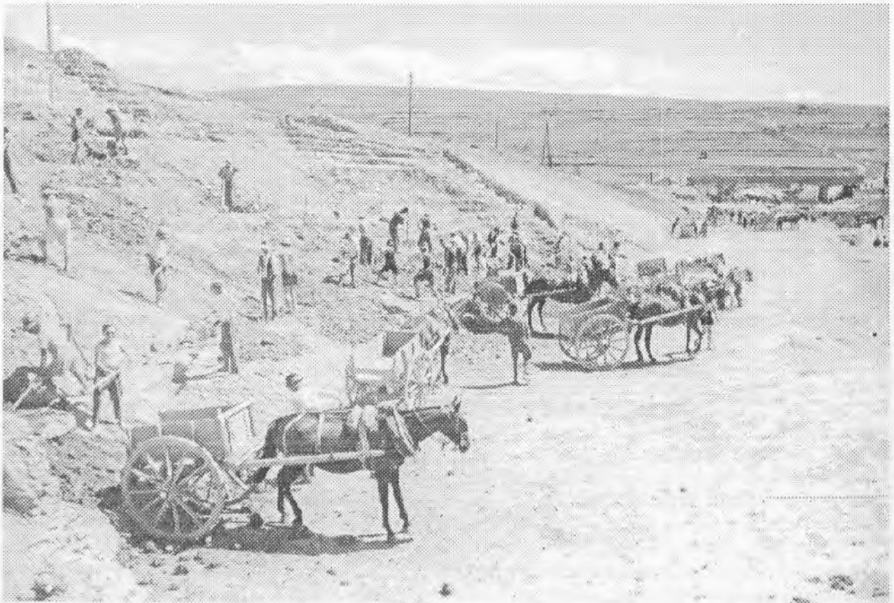
4. ábra Földmunka kivitelezése
