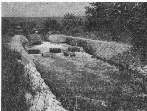
4. kép. Szellőztető padok az ülepítő után Pict. 4. Ventillation benches applied subsequently to supplementary segregation
