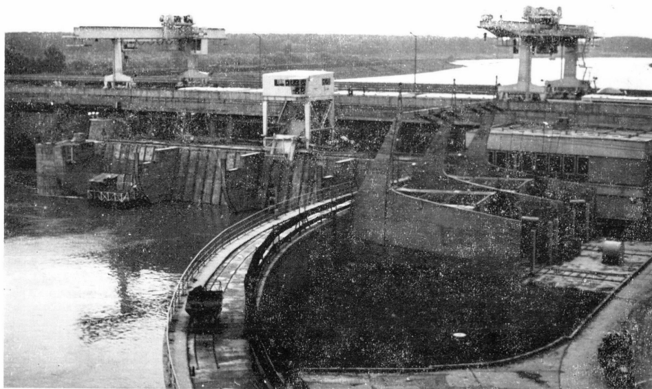
2. kép. A Tisza II. Vízlépeső áramfejlesztő egységei: négy esőturbina 560 m 3 víz másodpercenkénti hasznosítására, tehát egyenként 140 m 3 vizet nyelnek el; magyar—francia közös gyártmány. — A négy generátor együttes (névleges) teljesítménye 28 MW. A generátorok a turbinákkal közös tengelyen dolgoznak, végső évi átlagos villamos energiájuk 106 millió kWó lesz. A bal alsó negyedben a felvíz (duzzasztott víz), a jobb felső negyedben az alvíz látható. Fent két, síneken mozgó daru látható: ezek segítségével végzik a javításokat, alkatrészcsereket
