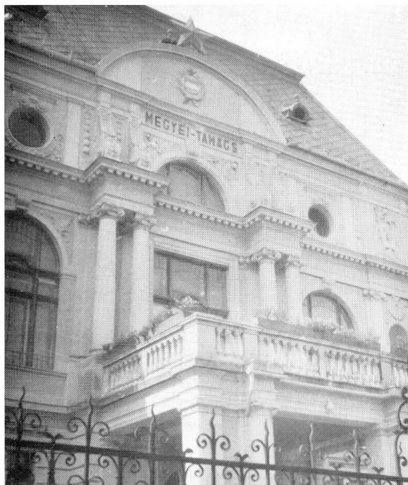
4. kép. A Megyei Tanács székháza Nyíregyházán. Nagyon szép elől a bábkorlátos (ballustrád) erkély és mögötte a kissé átalakított ion-oszloppár. Az épület több építészeti stílus elemét tartalmazza, tehát az ún. eklektikus stílushoz tartozik. Az elől levő vaskorlát kézi kovácsolású
