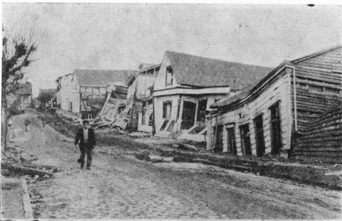
3. ábra. Az 1960. május 21-i földrengés okozta talajfolyás következtében megrongálódott faházak Valdiviában (Chile)
