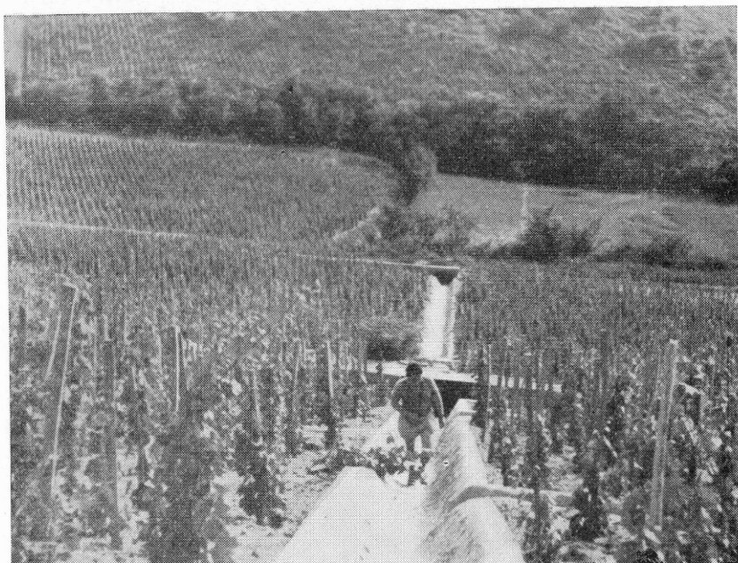
5. kép. A nagyüzemi szőlőművelés talajvédelme: kikövezett vízlefyelő a régebbi eróziós árok helyett. Szekszárd—Kálvária-hegy. (Foto: Dr. Pataki, 1961.)
