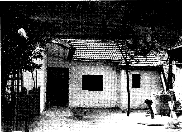
9. kép. Paks. Rókus u. — Dunakömlödi út. Lössbe mélyülő ház Paks. Rókus-Gasse — Dunakömlödi-Strasse. Das Haus in den Löss vertieft
