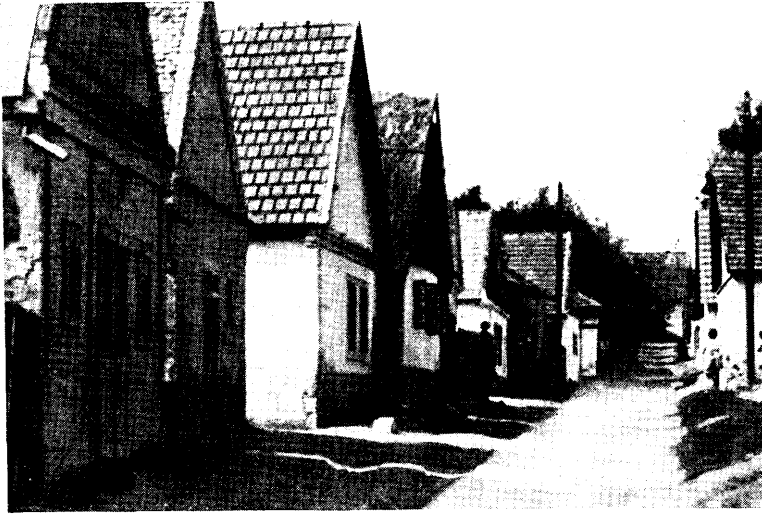
5. kép. Paks. Tavasz utca. Eredetileg prësházsor (Pince-völgy), későbbi lakóház építkezéssel Paks. Tavasz-Gasse. Ursprünglich Kelterhaus-zeile mit späteren Wohnhausbauten
