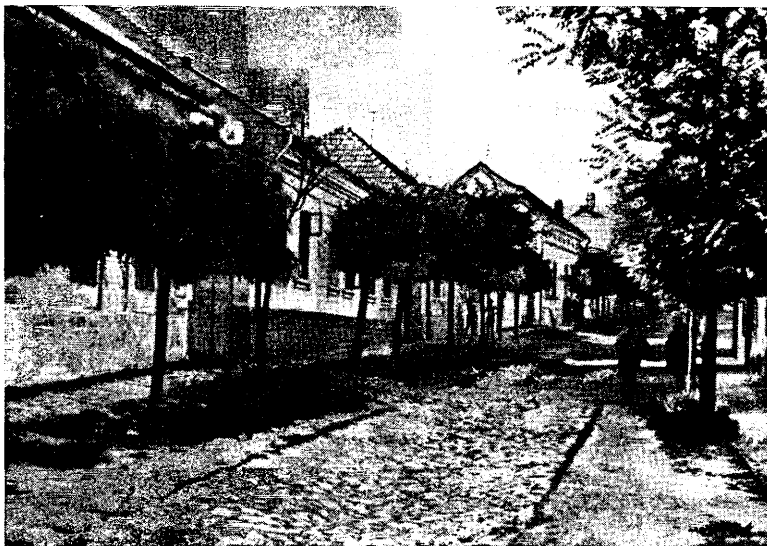
1. kép. Paks Duna utca. Kisvárosias, záródó házsor, az út közepe vályúszerűen kiköveztve az esővíz számára Paks, Duna-Gasse. Kleinstädtische, geschlossene Hauszeile. Mitte der Gasse zur Ableitung des Regenwassers, rinnenartig gepflastert
