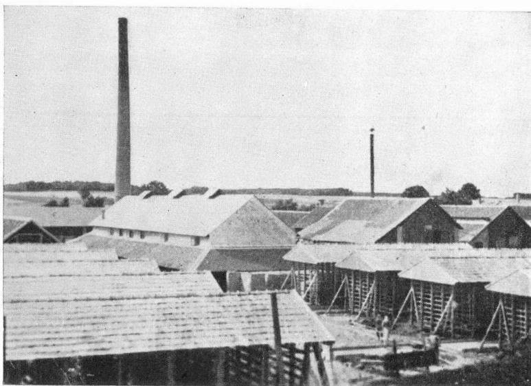
2. kép. Kisebb téglagyár körkemencével (kéménnyel) és Keller-rendszerű szárítószínekkel Kleinere Ziegelei mit Ringofen, Schornstein und Trockenschuppen (System Keller)
